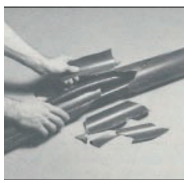
Retire los tuberías eléctricas dañados o defectuosos
