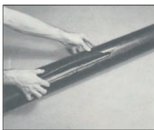
Encapsule el cable con el tubería eléctrica dividido* FRE®
